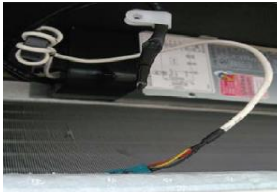
Провод ПДУ прикасается к теплообменнику
